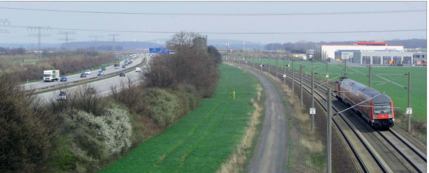
Parallel zur A 14 verläuft die Eisenbahn-Neubaustrecke, die das Stadtzentrum mit dem Flughafen verbindet.
