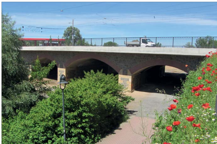
Die Erneuerung von Straßenbrücken bindet einen erheblichen Anteil des Etats. Bei der Lützenbrücke im Zuge der Lützner Straße wurden die Maßnahmen 2012 abgeschlossen.
