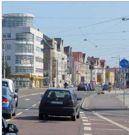
An der Lützner Straße wird der Städteingang nach Lindenau durch ein besonderes Gebäude markiert.
