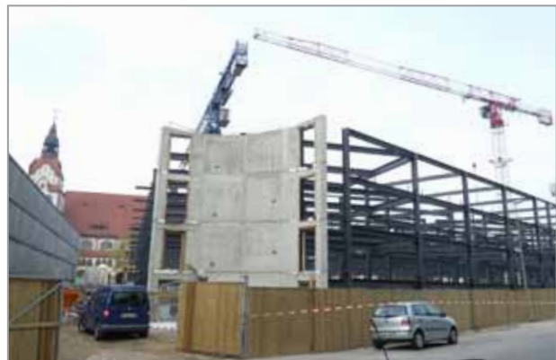
▲ Foto: Neubau zweites Zooparkhaus
