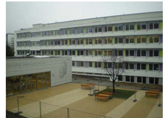
Passivhauschule – Wilhelm-Ostwald-Gymnasium Leipzig
