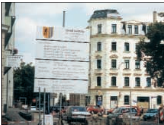
Knoten Holzhäuser Straße/Zuckelhäuser Straße/Sommerfelder Straße August 1999
