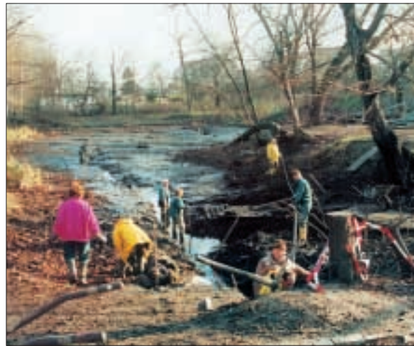
Sanierung Gutsteich, am Stötteritzer Wäldchen, 1997
