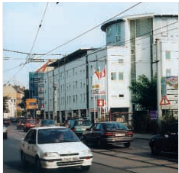
Holzhäuser Straße/Ecke Kolmstraße, 1997
