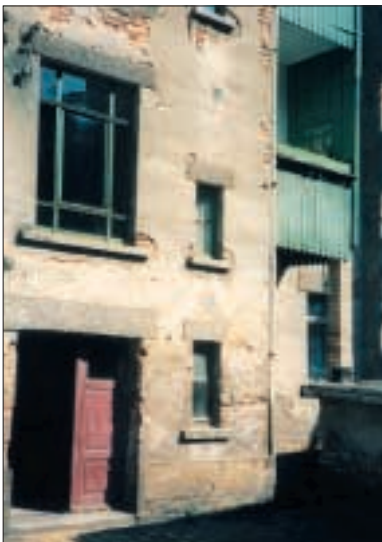
Ferdinand-Jost-Straße 64, Hofansicht, Juli 1997
