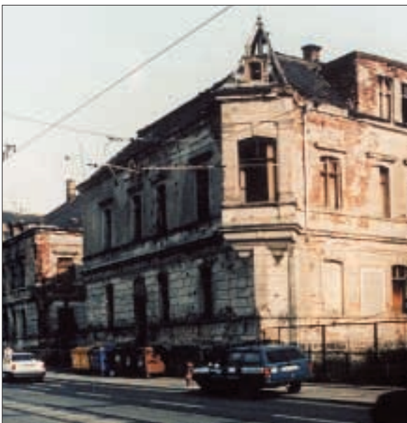
Holzhäuser Straße/Ecke Kolmstraße, 1993
