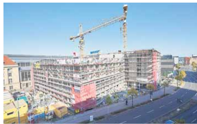
Der Rohbau steht: Voraussichtlich in einem Jahr eröffnen hier zwei neue Hotels. Foto: S&G Development/Sven Voss
