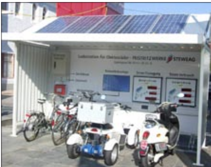
Abb.3: Ladestation für E-Fahrräder Feistritzwerke STEWEAG
